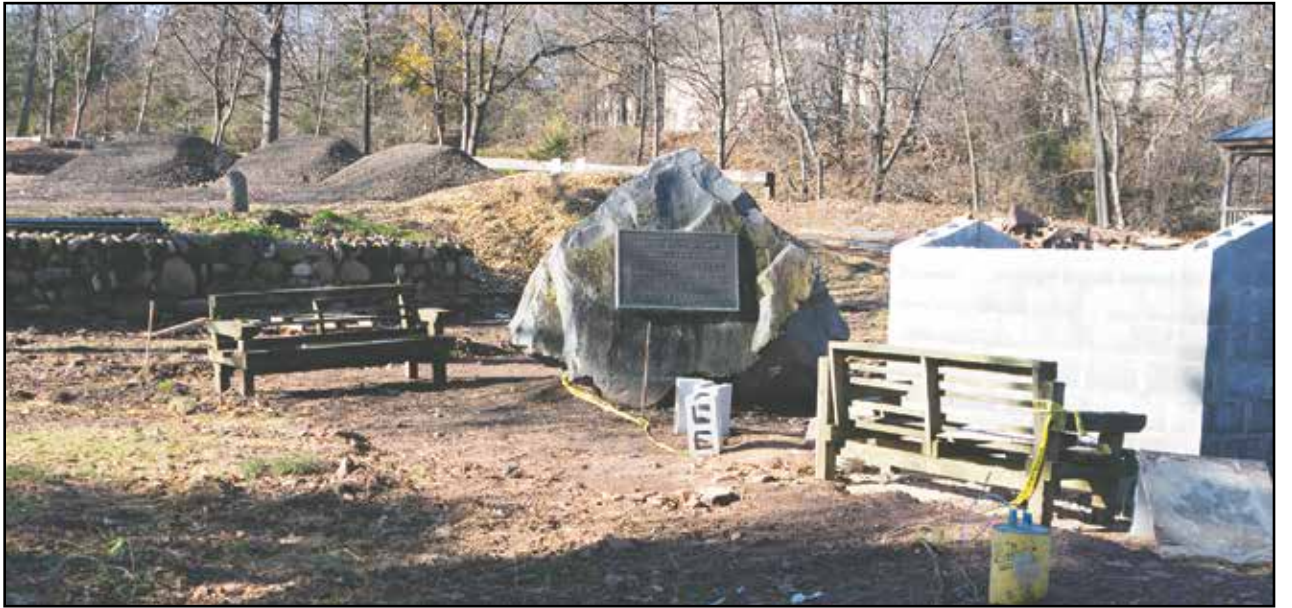
EL CONDADO ASUME EL CONTROL – El condado de Somerset renovará el Parque Conmemorativo Guglielmo Marconi después de que los funcionarios detuvieran el trabajo no autorizado que estaba realizando la Fundación Marconi del Municipio de Franklin.
